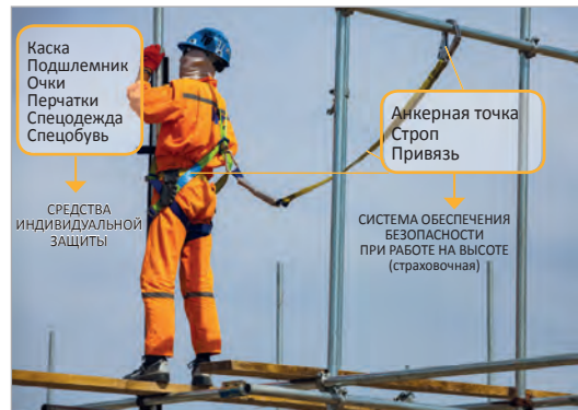
Рис. 1. СИЗ и система обеспечения безопасности при работе на высоте
